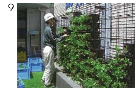
設置「Pixel Pot」植栽籃(由下往上一個個依序堆疊)
