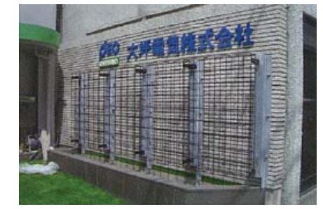
植栽框架「Pixel Frame」固定完成
