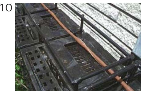
鋪設「自動滴灌管」(每6段植栽籃鋪設1列滴灌管)
